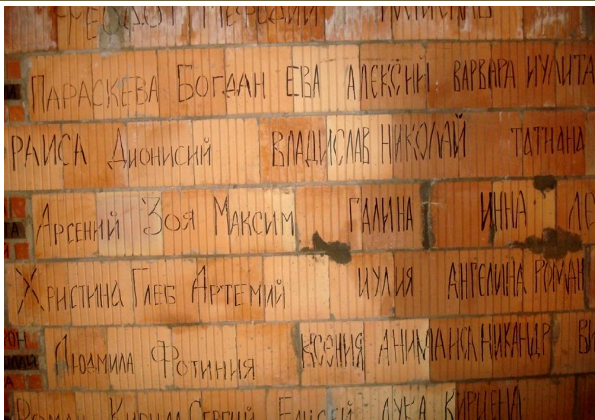
Фрагмент интерьера строящегося храма с надписанными «именными кирпичиками». Декабрь 2017 года
